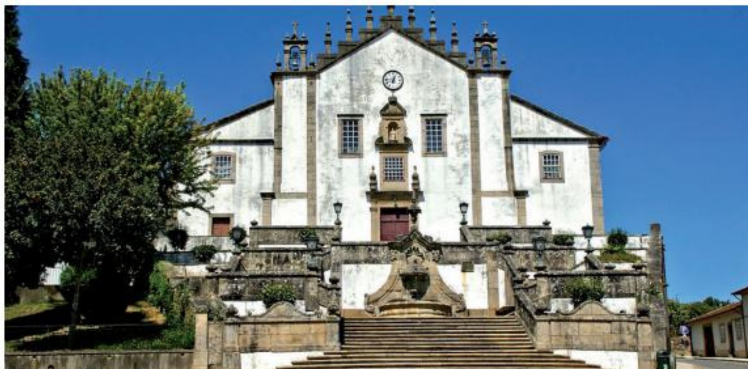
Projecto de reabilitação da Igreja da Misericórdia
